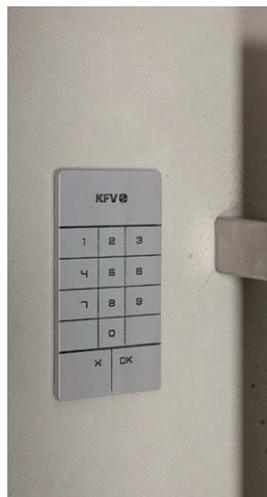
Zahlencode-System zur Bedienung eines elektrischen Motor-Schlosses, Bedienfeld auf Türblatt platziert.
